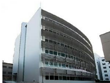
新研究棟（技術交流館）
